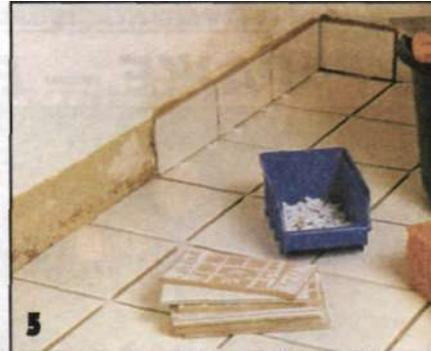
*Цоколь высотой ~75 мм выкладывают из разрезанных пополам плиток. Можно сделать цоколь и пониже, выкроив из целых плиток более узкие пластины.*
