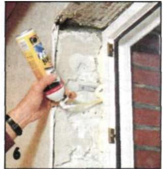
*Щели между оконной коробкой и стеной уплотняют пеной (желательно экологически чистой).*
