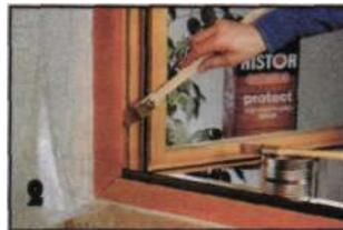
*Защитный слой грунта наносят в два слоя.*
