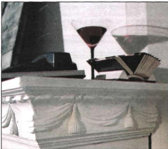
Эта впечатляющая деталь интерьера изготовлена из простых материалов. В основе - каркас из ДСП, на который наклеен фриз из пеноматериала. Всю конструкцию крепят к стене и отделывают.
