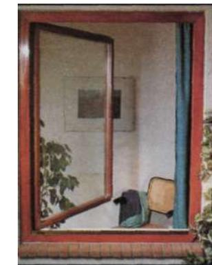
*Текстура, проступая сквозь покрытие, по-прежнему радует глаз, однако древесина приобрела другую окраску. Нанесенная толстым слоем лазурь защищает деревянную раму от атмосферных воздействий.*
