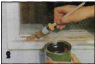
*Обработка подготовленных под отделку деревянных деталей пропиточным грунтом.*
