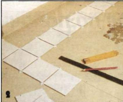
*Сначала у ровной стены укладывают для пробы один ряд плиток без раствора и под прямым углом к нему - второй, предварительно разметив соответствующие линии на полу.*
