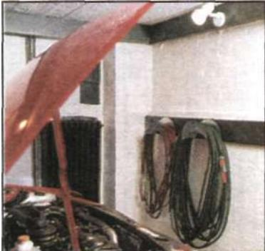
*Универсально: карниз, укрывающий трубы, служит одновременно для прокладки проводки и крепления светильников.*
