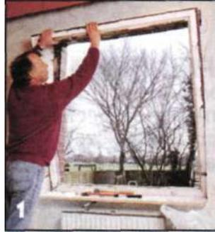
*Удалив обшивку и крепежные пластины, снимают старое окно.*
