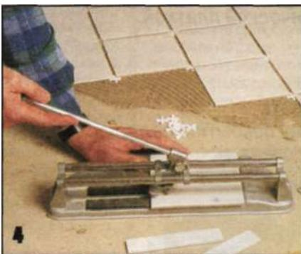
*Цокольные плитки и вставки раскаивают с помощью плиткореза, режущим элементом которого является твердосплавное колесико. Плитки ломают по надрезу.*
