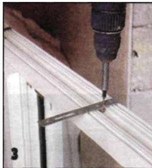
*Сбоку к оконной коробке пластикового окна привинчивают крепежную пластину.*
