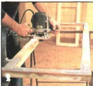
*Фальц можно углубить с помощью фрезерной машинки. Если бруски еще крепкие, проблем с этим не будет.*
