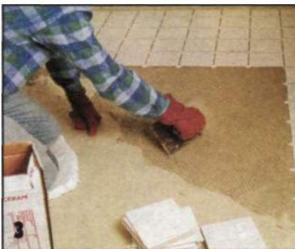
*Широкой зубчатой кельмой клеевой раствор распределяют тонким слоем по участку основы, который можно покрыть плиткой в течение 10-15 мин. Укладываемые плитки плотно прижимают к основе, слегка поворачивая их из стороны в сторону. Шовные крестовины обеспечивают одинаковую ширину швов.*
